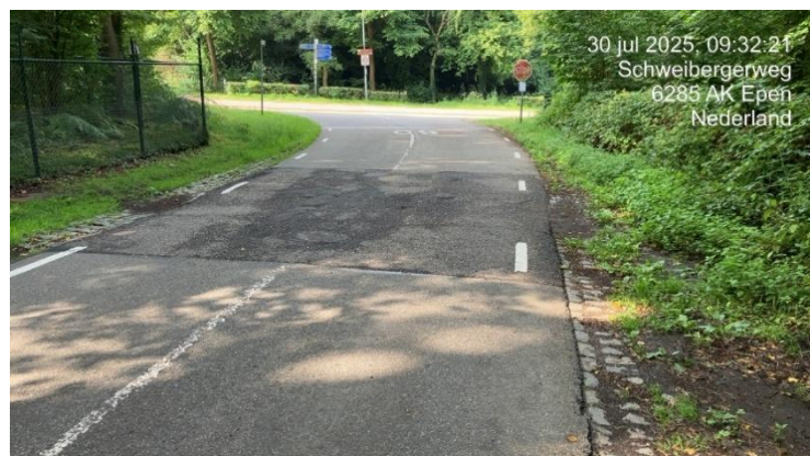
Nieuwe asfalt tussenlaag + toplaag (machinaal!)> vlakheid!
