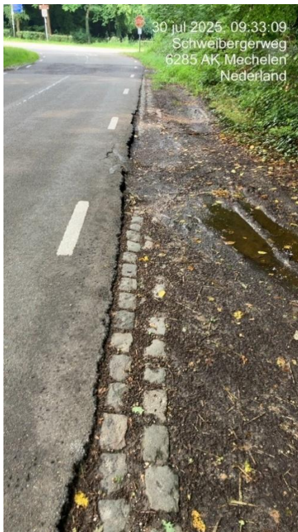
Reparatievak langs keienopsluiting
