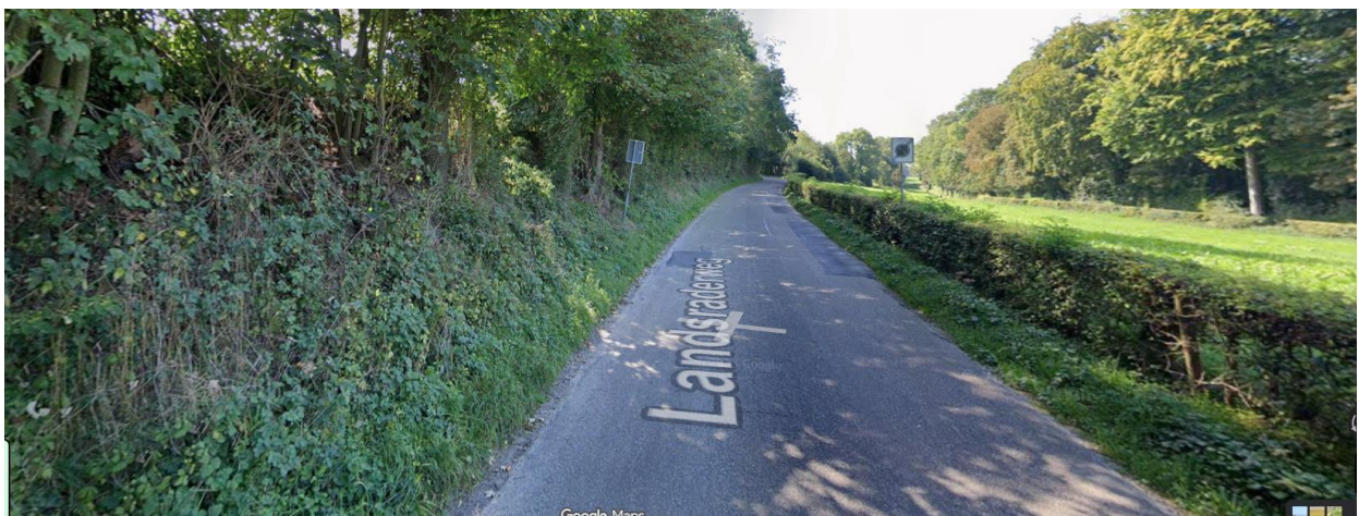
Zorgdragen dat water via berm (onder de haag door) kan afwateren. Na overlaging bermen beoordelen en niet te hoog aanvullen
