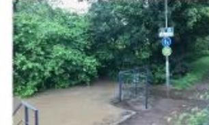
5 Buffer bovenstrooms van de beek - stroming door de duiker en aanvoer van rommel te reguleren
