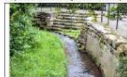
4 Verbeteren doorstroming beek - frequent onderhoud tegen vuil- en slibafhoping
